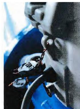
Sichern Sie das Impulskabel gegen Manipulation über die Zählerhaube. Dafür ziehen Sie den Draht durch die Ösen an der Inbus-Schraube und durch die Kunststoffhaube und fixieren diesen mit einer Plombe
