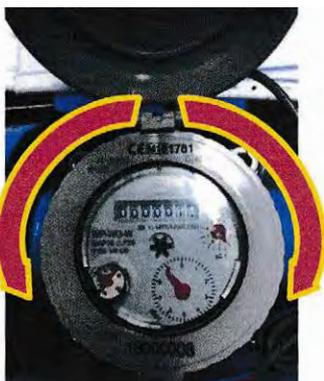
Wurde die Montage der Haube richtig ausgeführt, lässt sich die Kunststoffhaube zusammen mit dem Messeinsatz in die gewünschte Ausrichtung drehen
