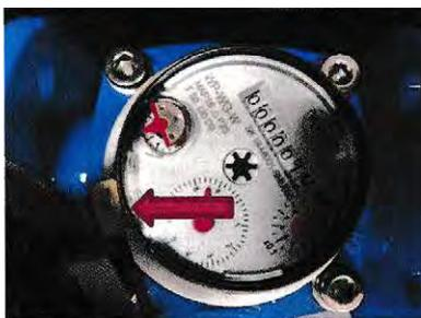
Impulskabel in die Führungsschiene fahren
